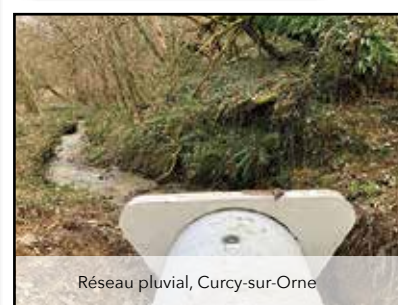
Réseau pluvial, traversée de rue à Curcy-sur-Orne
